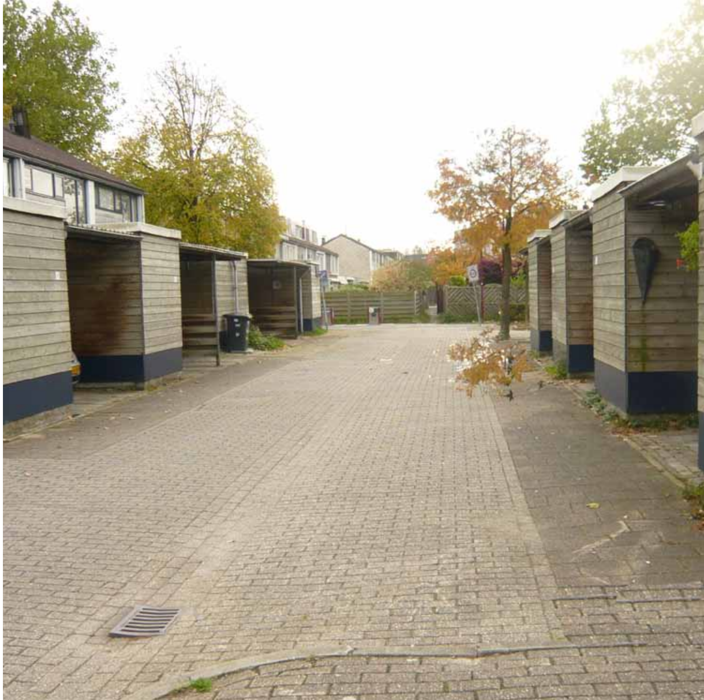
De vergrijsde bergingen aan de voorzijde spelen een belangrijke rol in de grijze uitstraling van de wijk.
