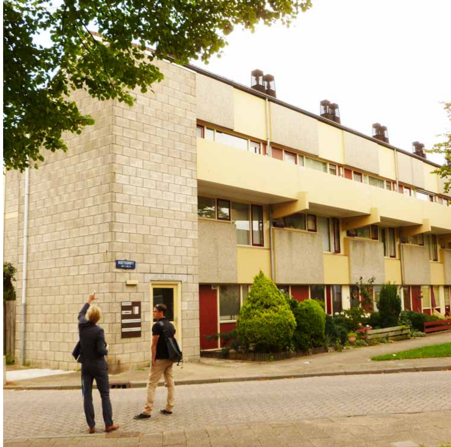
Gesloten entrees en verouderde kleurstelling maken de galerijblokken in zichzelf gekeerd en weinig verbonden met de wijk
