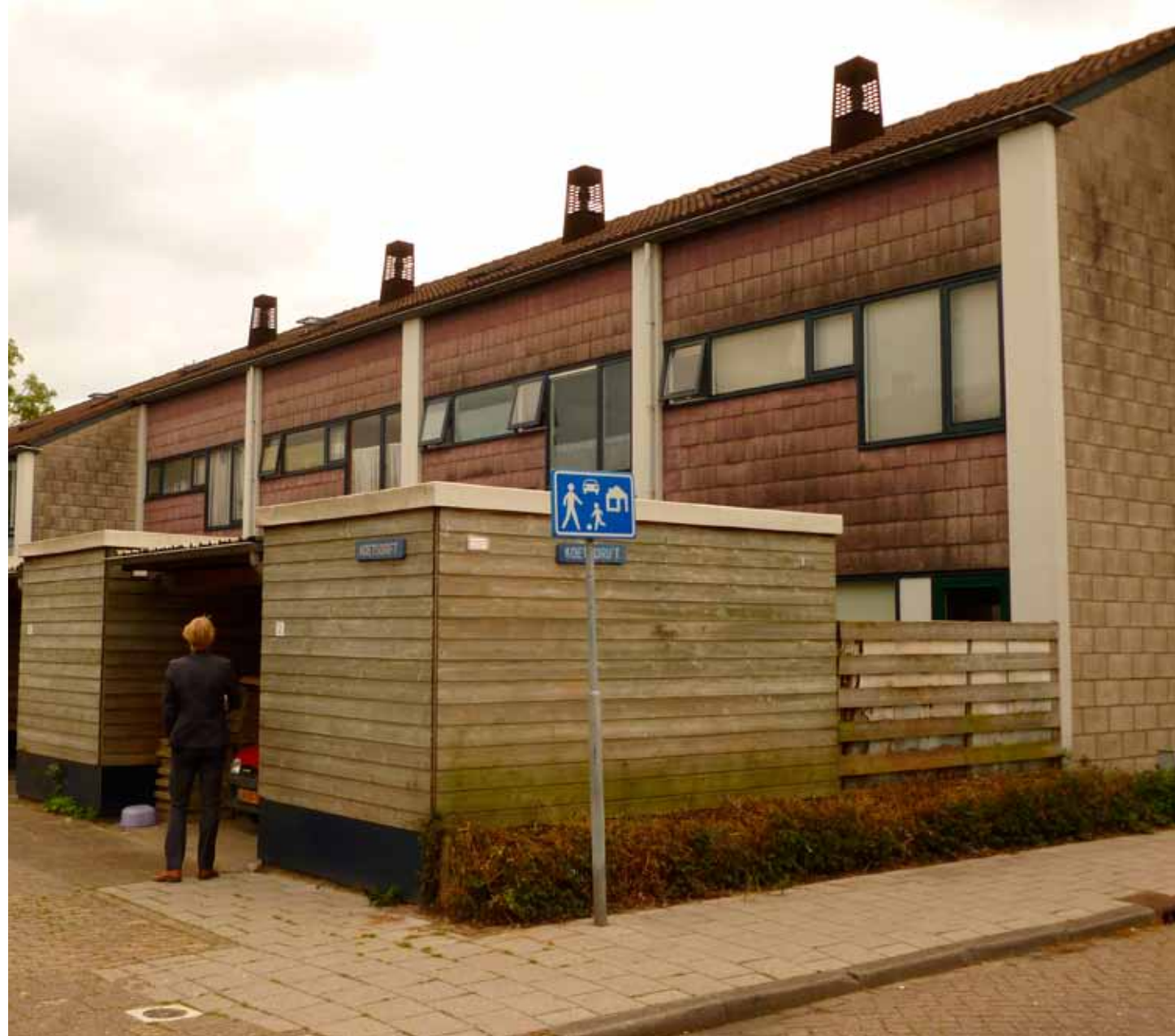
Uitstraling van de woningen is sterk verouderd, maar de onderliggende structuur biedt veel mogelijkheden
